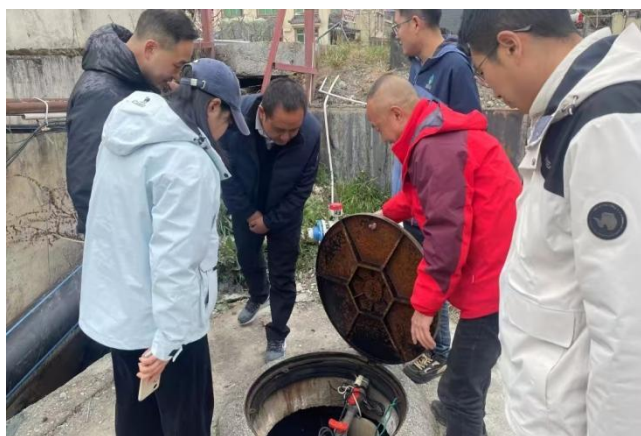
现场检查农村生活污水治理
